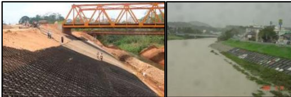
شکل پ.۴-۱۸- حفاظت طبیعی - سازه‌ای دیواره‌ی رودخانه در بالادست پل
