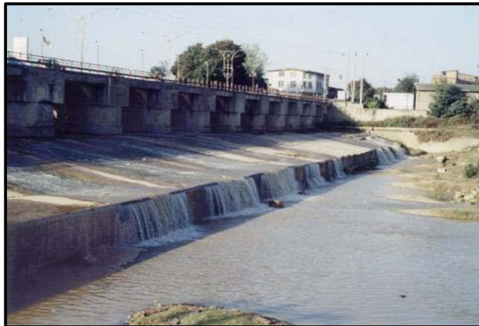
شکل ۳-۸۷- مانع پل تجن
