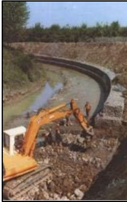
شکل پ.۴-۱۷- دیواره تورسنگ در حفاظت دیواره پایین پیچ
